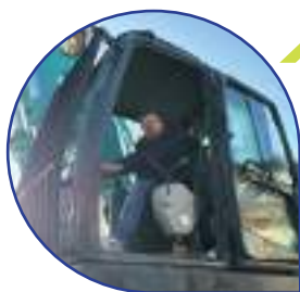
Page 4 Travaux de la piscine intercommunale
