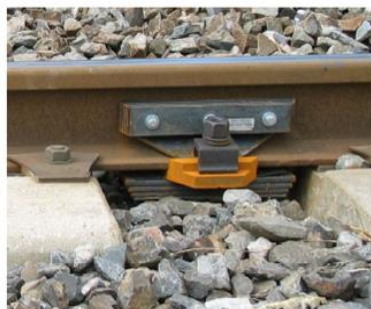
Absorbeur de vibrations sur rail (source SNCF)
